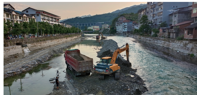
河道清淤提质增效工程施工现场
