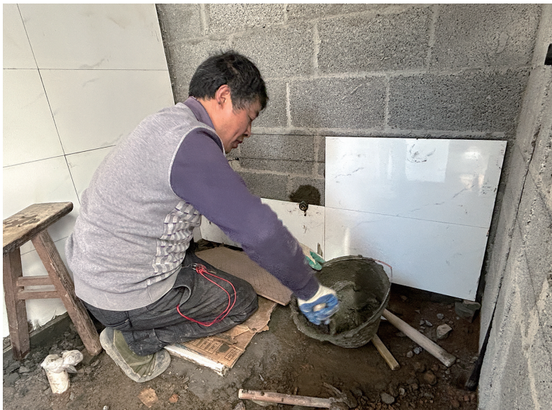
施工人员正在作业中
