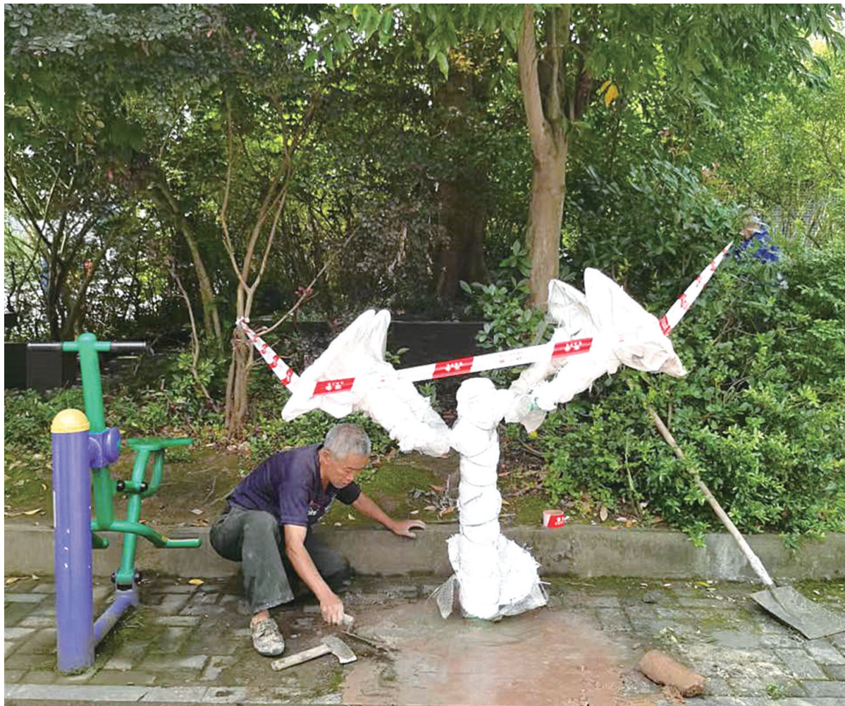
工人正在安装健身器材
