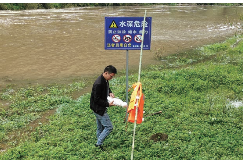
工作人员在危险水域设置警示牌、救生杆和救生圈
