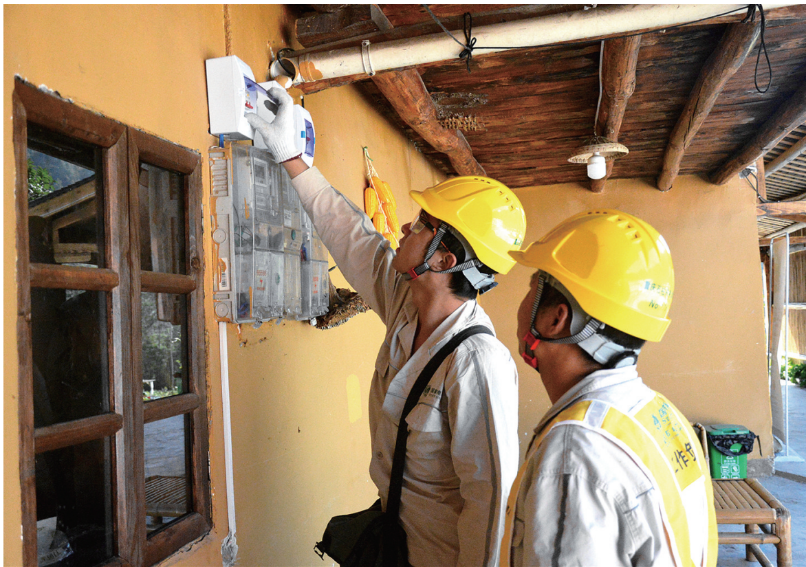
电力工人在检查安全隐患(本报资料图片)
