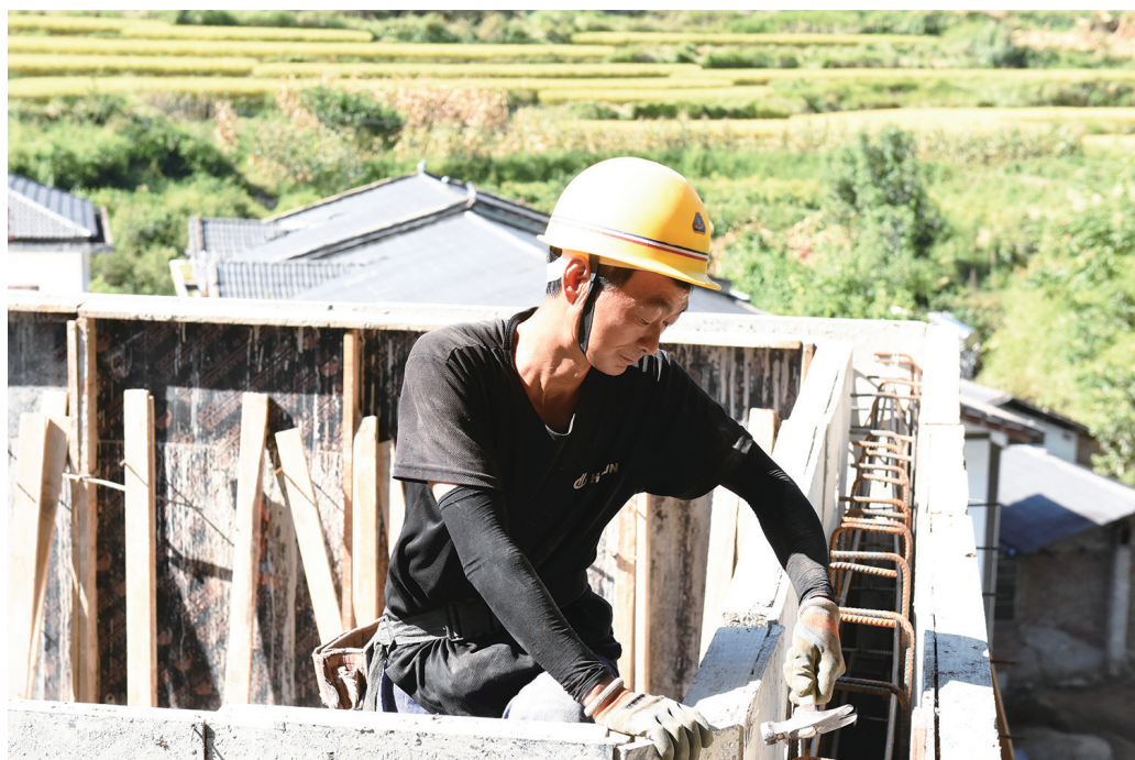
盛夏时节,施工人员在加紧施工建设森林消防水池
