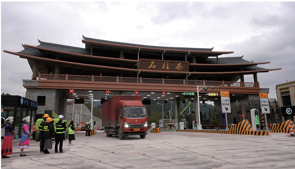
车辆经过改造后的石柱西收费站
