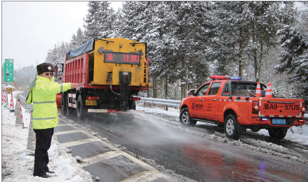
G50沪渝高速石柱至冷水段开展融雪撒布作业 记者 谭艳波 摄
