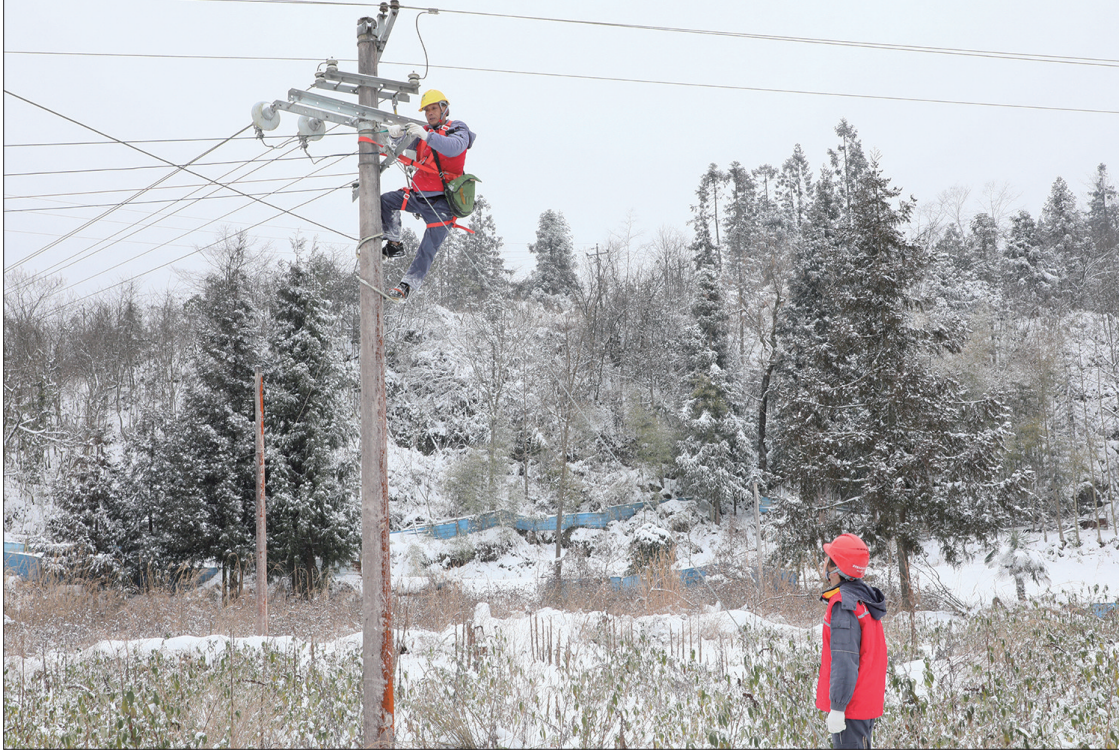
工作人员在10千伏龙马线老厂坪台区检修 通讯员 刘国政 摄
